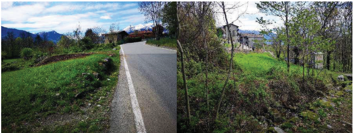
Fig. 3 - Tratto a monte dell'attraversamento del t. Rigorsa / Fig. 4 – Tratto a valle
