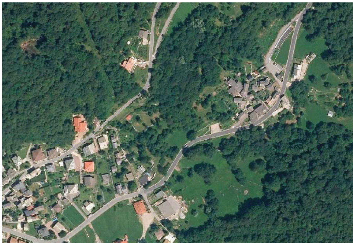
Fig. 5 – Foto aerea delle aree oggetto di intervento
