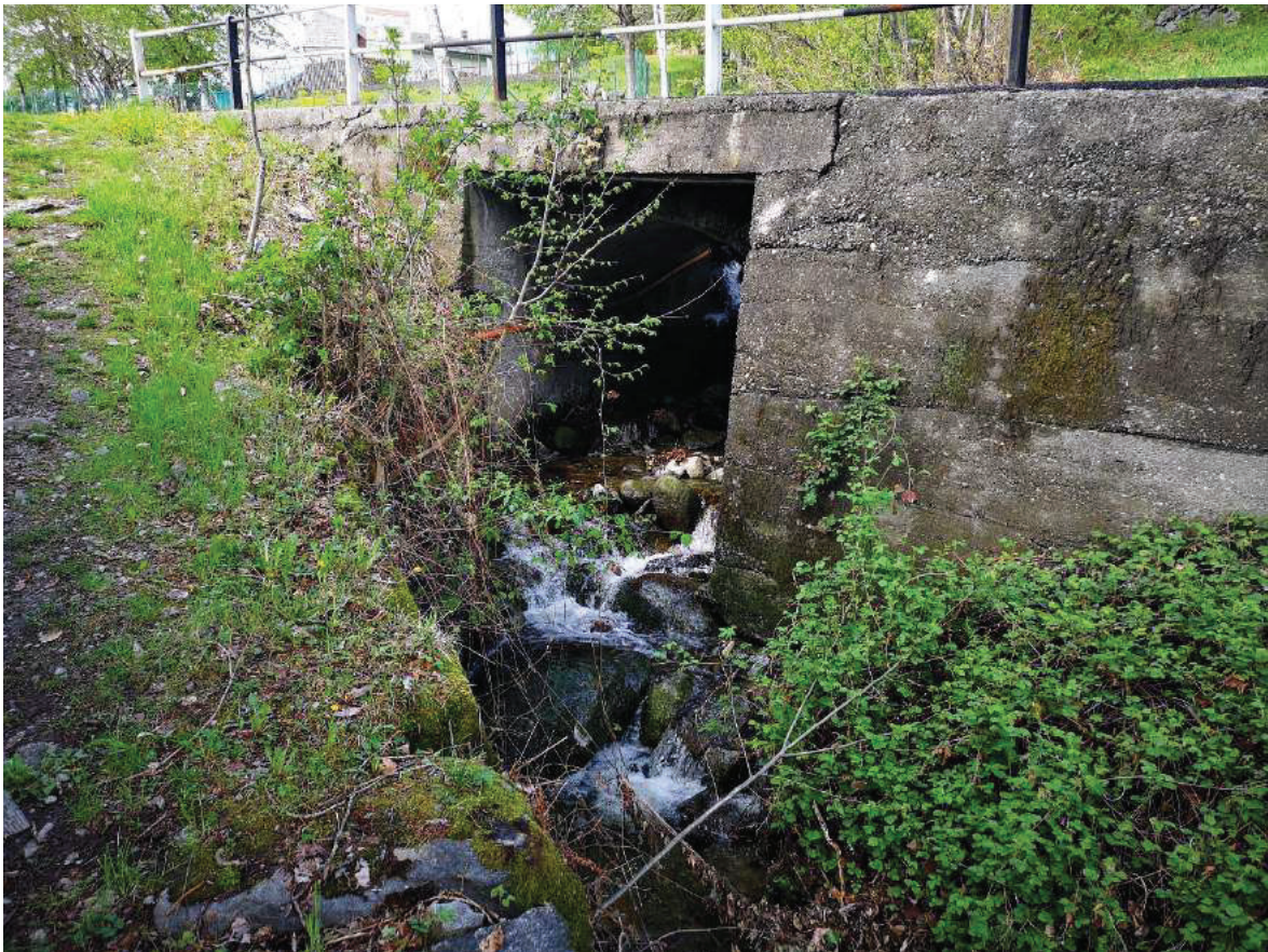
Fig. 13 – Tombotto di attraversamento della SP10 - t. Rigorsa
